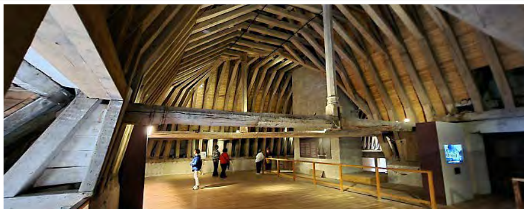
Obr. č. 8 – Pohled do pôvodného krovu
