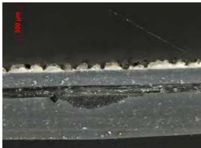
Obr. č. 3 – Příklad destrukce vrchní UV stabilizované vrstvy fólie mPVC
