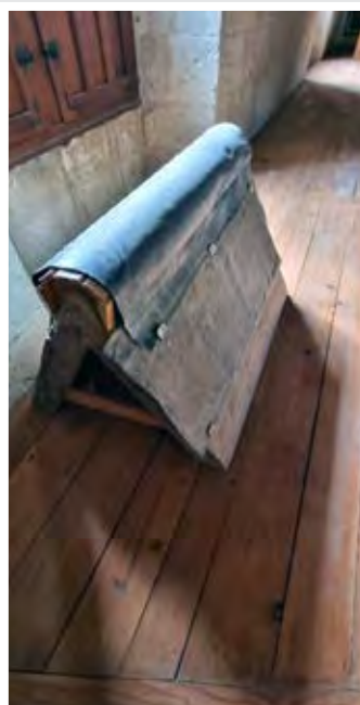
Obr. č. 9 – a, b – Původní klempířské řešení hřebenu střechy, které se stalo součástí zámecké expozice, c, d – Nově provedené klempířské prvky na střeše zámku
