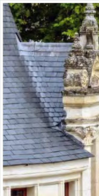
Obr. č. 9 – a, b – Původní klempířské řešení hřebenu střechy, které se stalo součástí zámecké expozice, c, d – Nově provedené klempířské prvky na střeše zámku
