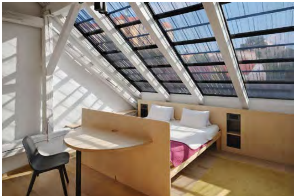
Systém Nebesys v instalaci na hotelu Duo v Mikulově - pohled zevnitř
