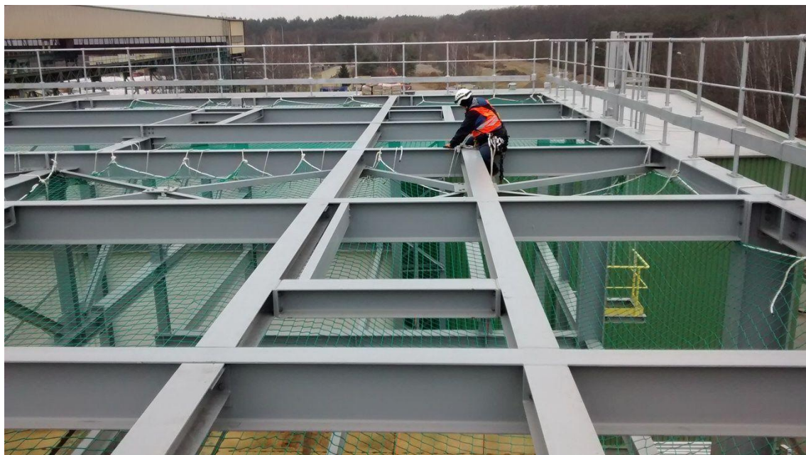
Obr. č. 3 – ukázka instalace záchytných sítí před pokládkou trapézových plechů
