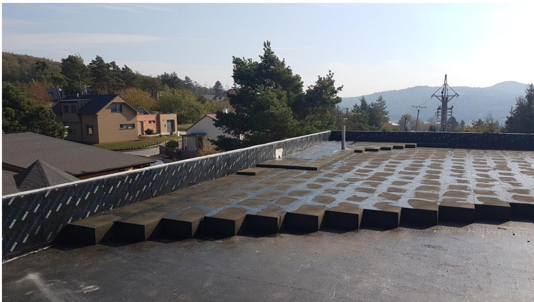
Kompaktní skladba FOAMGLAS lepená do horkého asfaltu
