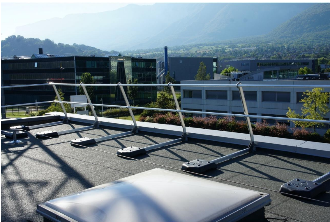
Obr. č. 2 – volně stojící zábradlí na okraji střechy
