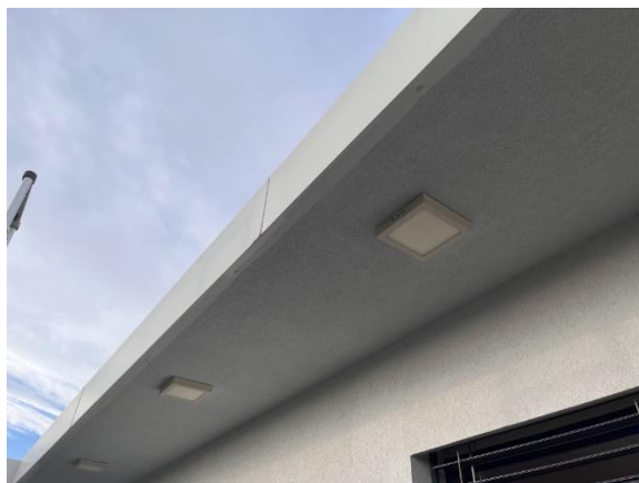
Obr. 2 - RD Praha, přesah střechy
