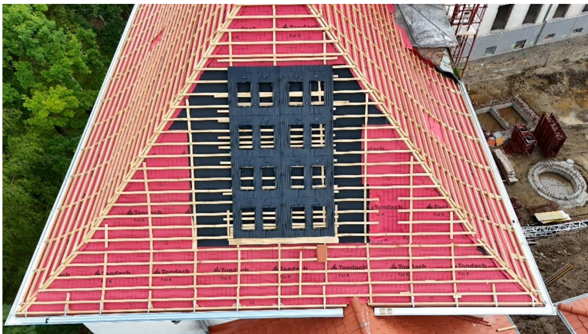
Obr. 4 Systém X-Frame FV sa inštaluje priamo na strešné latovanie, bez potreby ďalších konštrukcií. Zdroj: wienerberger
