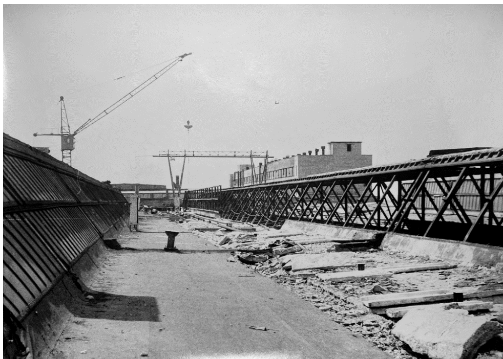
Obr. 1. Celkový pohľad na existujúce (na fotografii vľavo) a nové konštrukcie svetlo-aeračných svetlíkov (v zóne práce portálového žeriavu).
