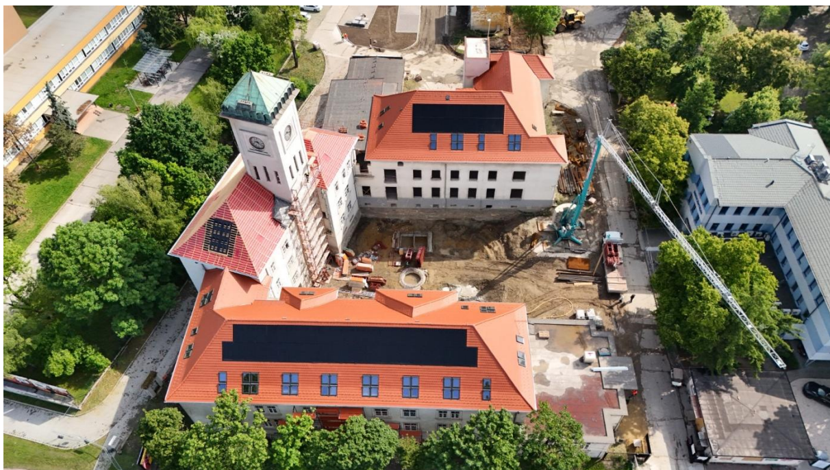
Obr. 3 Inštalácia fotovoltického systému X-Frame FV na strechu bývalej nemocnice na Kapisztoryho ulici v Nových Zámkoch. Zdroj: wienerberger
