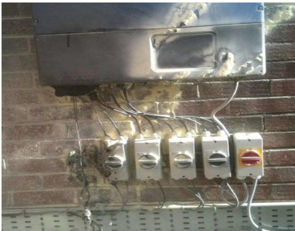
Obrázok 10 Následky lokálneho požiaru, pri ktorom je ľavý DC oddeľovač úplne zničený ohňom, pričom došlo k vedľajšiemu poškodeniu susedného oddeľovača a invertora nad ním [9].
