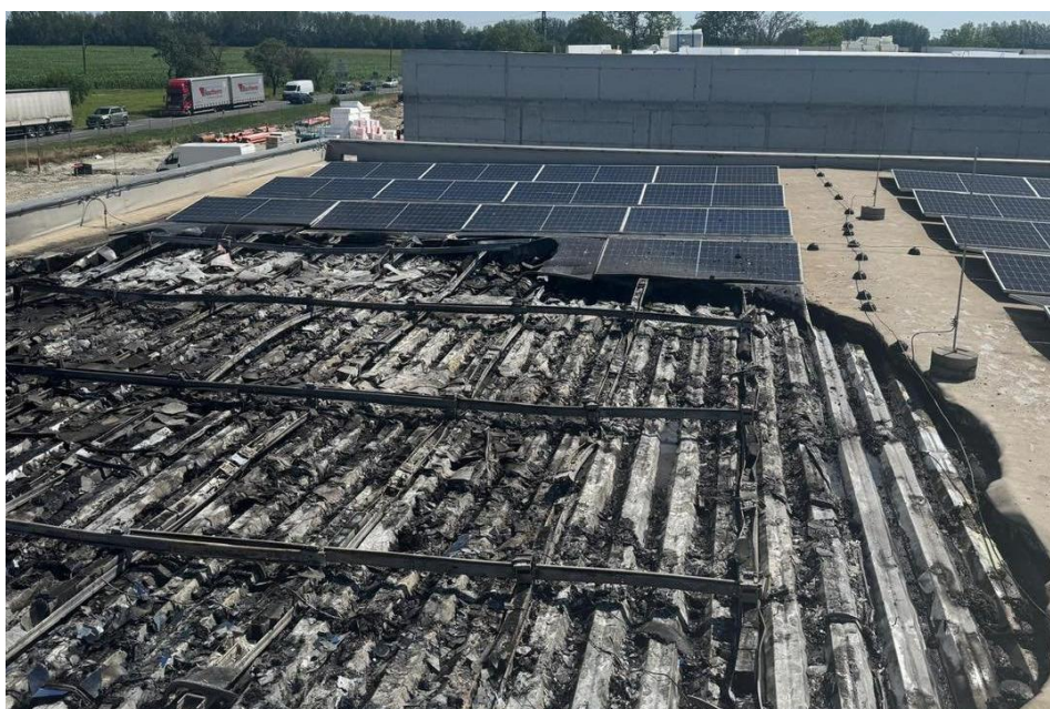
Obrázok 8 Požiar FV na streche predajne áut v Dunajskej Strede – pohľad na strechu (21. júl 2025) [8].
