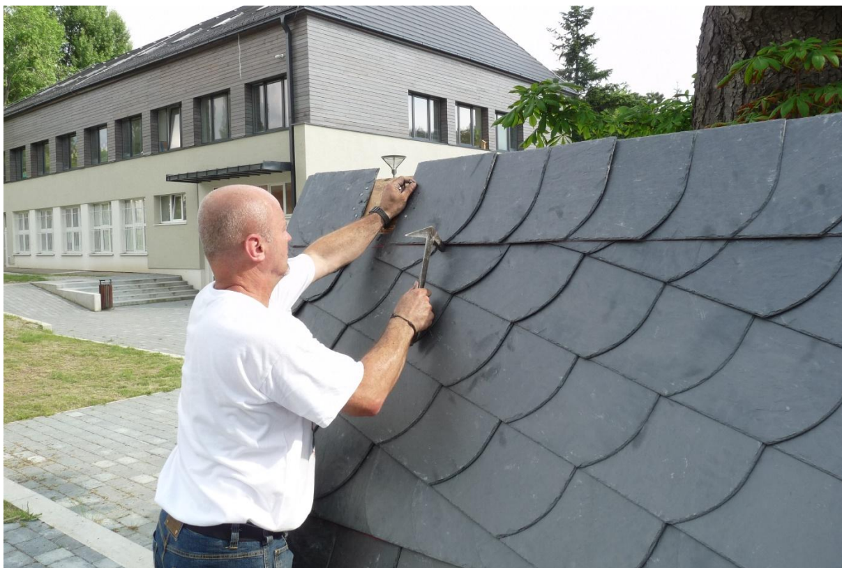
Obr. 10 Ukážka pokrývania strechy bridlicovou krytinou spoločnosťou Topstein počas odborného seminára v Marianke, foto: Jozef Kráľ
