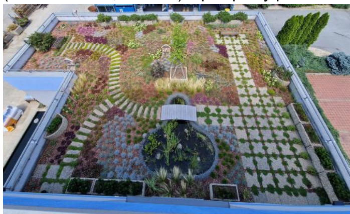
Obr. 2 Fotografia severnej vegetačnej strechy s napojením na mokraďovú strechu.
