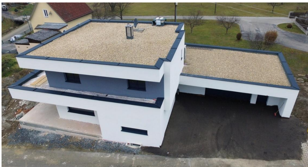
Obr. 7 Realizácia plochej strechy pomocou Austrotherm Atikového prvku
