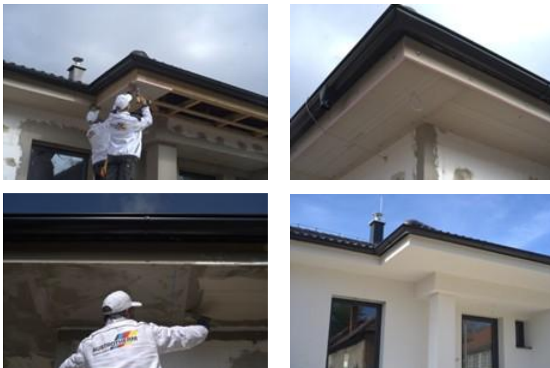
Obr. 9 Realizácia podbitia pomocou Austrotherm Uniplatne
