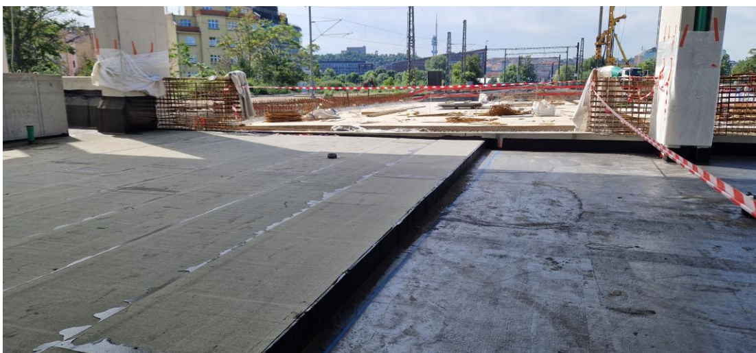
Podkladní asfaltový pás na kompaktní skladbě lepený do horkého asfaltu
