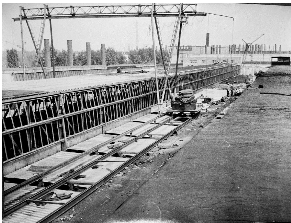
Obr. 2. Celkový pohľad na pracovnú zónu portálového žeriavu, elektrického vozíka s podanou tepelnou izoláciou na montáž a umiestnenie koľajníc, ktoré sú prostredníctvom kovových krátkych podpier pripevnené k hornému pásu väzníkových nosníkov: a — svetlo-aeračný svetlík po rekonštrukcii, na ktorom sa vykonávajú práce na pokládke doskovej tepelnej izolácie na profilovaný plech; b — bližšie k nám vpravo, pohľad na existujúcu strechu svetlo-aeračného svetlíka pred začiatkom prác na jeho rekonštrukcii.
