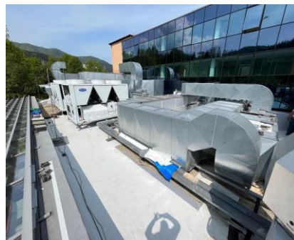
(strecha, ktorá má 600 m 2 a 500 m 2 vzduchotechniky)
