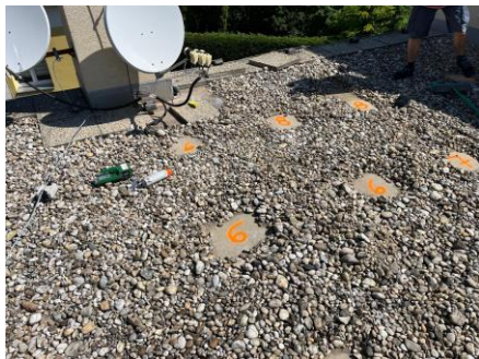
(sondové meranie vlhkosti na streche zasypanej štrkom)
