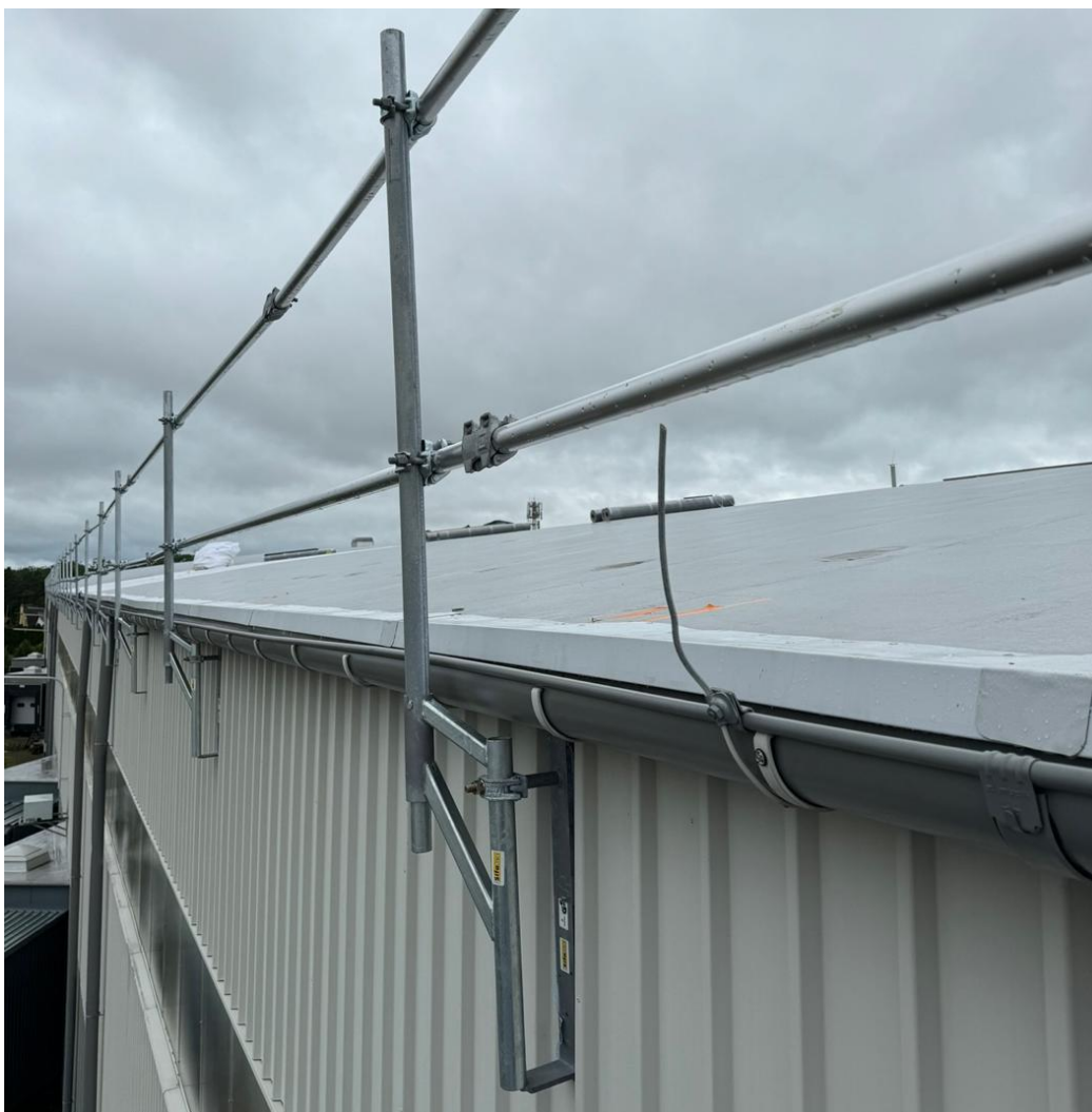
Obr. č. 4 – ukázka instalace dočasného zábradlí na stavbě
