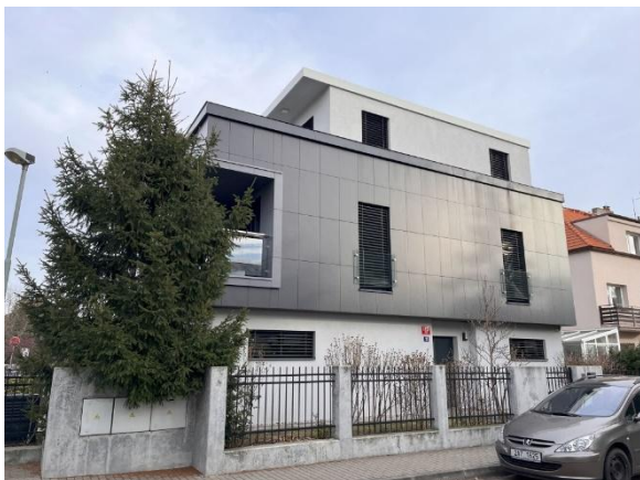
Obr. 1 - RD Praha, pohled od jihu
