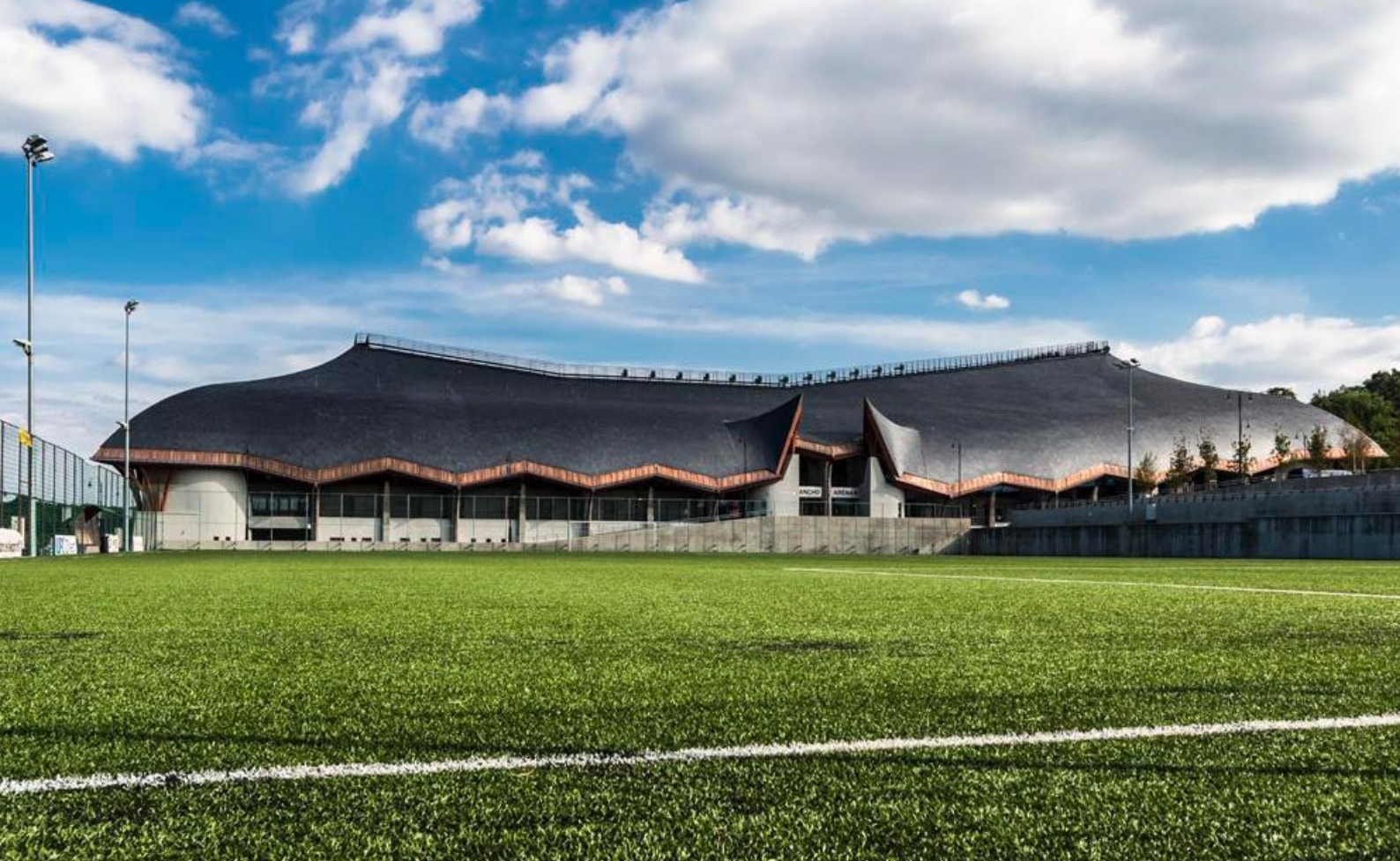
Niekoľko pohľadov na futbalový chrám.
